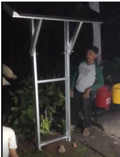
Gambar 6. Proses pemasangan penyangga dan panel surya 2x100Wp bersama mitra.
