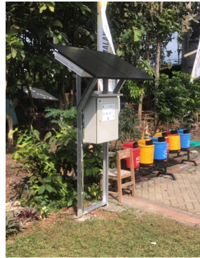
Gambar 7. Hasil pemasangan PLTS 2x100Wp.
