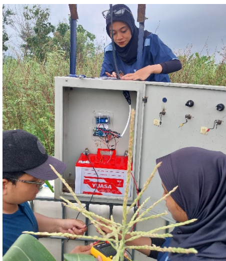
Gambar 5. Pemasangan baterai pada box panel
