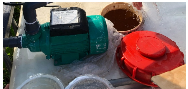
Gambar 3. Pemasangan pompa air DC
